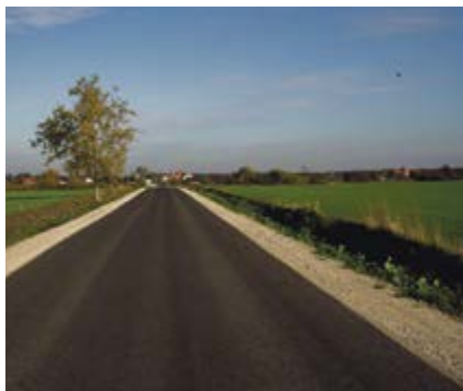
Remont drogi Mieścisko – Budziejewko kosztował blisko 1 mln zł.
