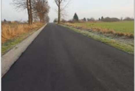
Remonty to także tzw. bieżące utrzymanie – na zdjęciu droga do Piotrkowcu.
