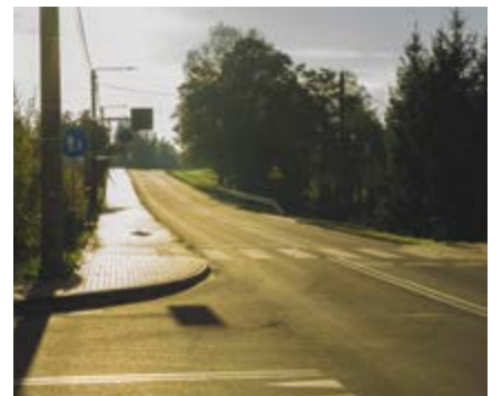
Przebudowa ul. Antoniewskiej w Skokach realizowana była w ramach Funduszu Dróg Samorządowych.
