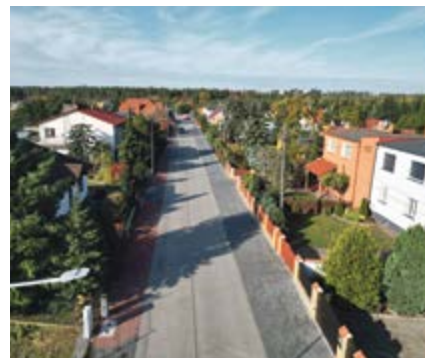
Ul. Grzybowa w Wągrowcu po przebudowie.
