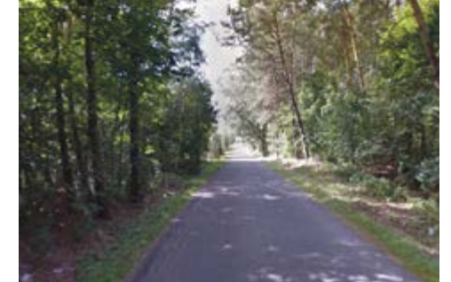
Droga Mirkowice - Gruntowice przed przebudową.
