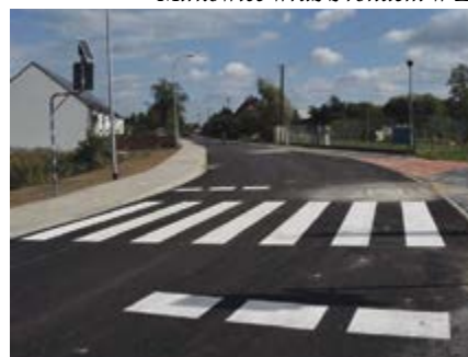
Przebudowa ul. Nad Nielbą w Wągrowcu.
