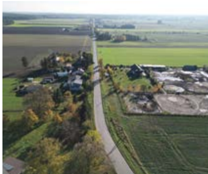
Rozbudowa drogi w Przysieczynie wraz z ścieżką pieszo – rowerową wykonana zostanie za ponad 10 mln zł.
