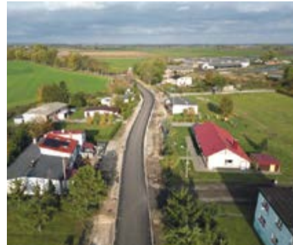
Przebudowa drogi w Kołybkach to jedno z wielu zadań dofinansowanych ze środków zewnętrznych.
