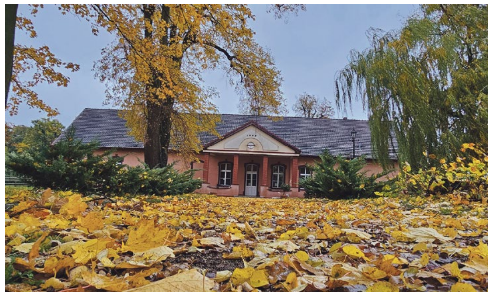
Ośrodek Kultury Strzelnica przed remontem, fot. NCK Wielień
